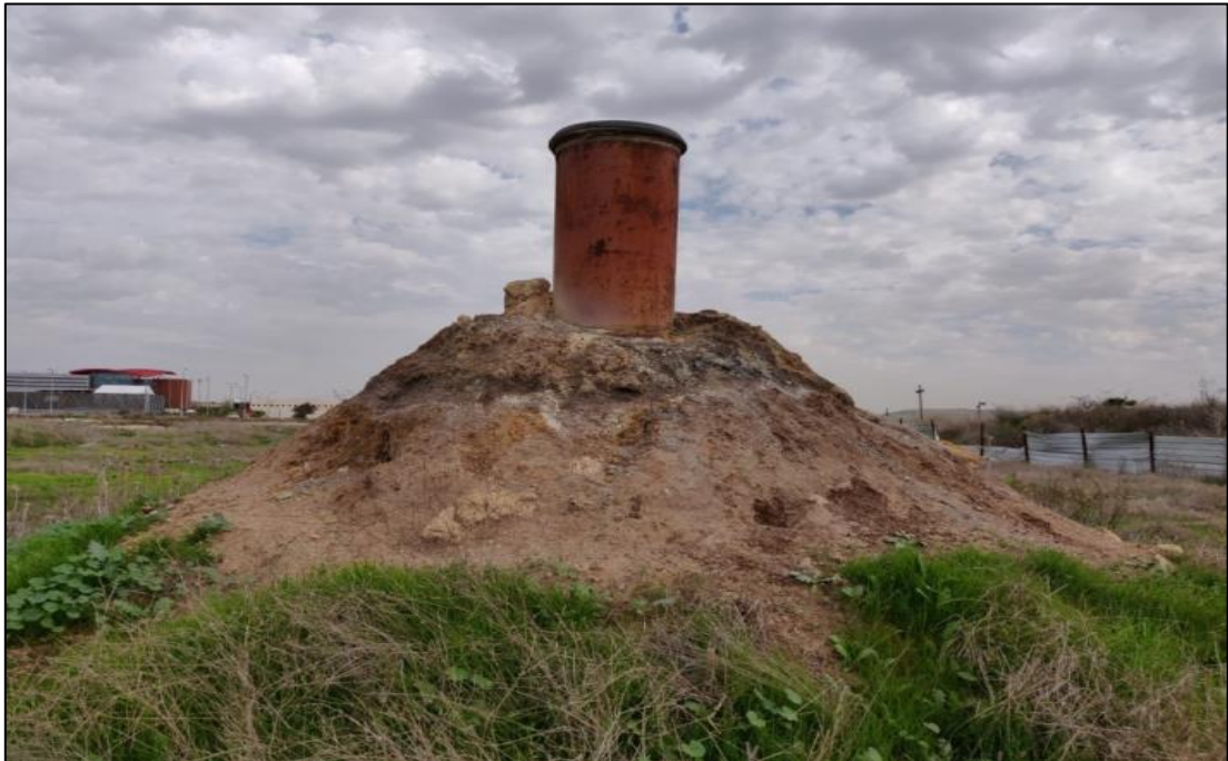
איור 36 – פיר לשאיבת תשטיפים באזור מגרש 19 (מרכז האתר). ניתן לראות סימני כהים המעידים על פליטת גזים וכן להבחין כי לא קיימת צמחיה על גבי תלולית העפר.
