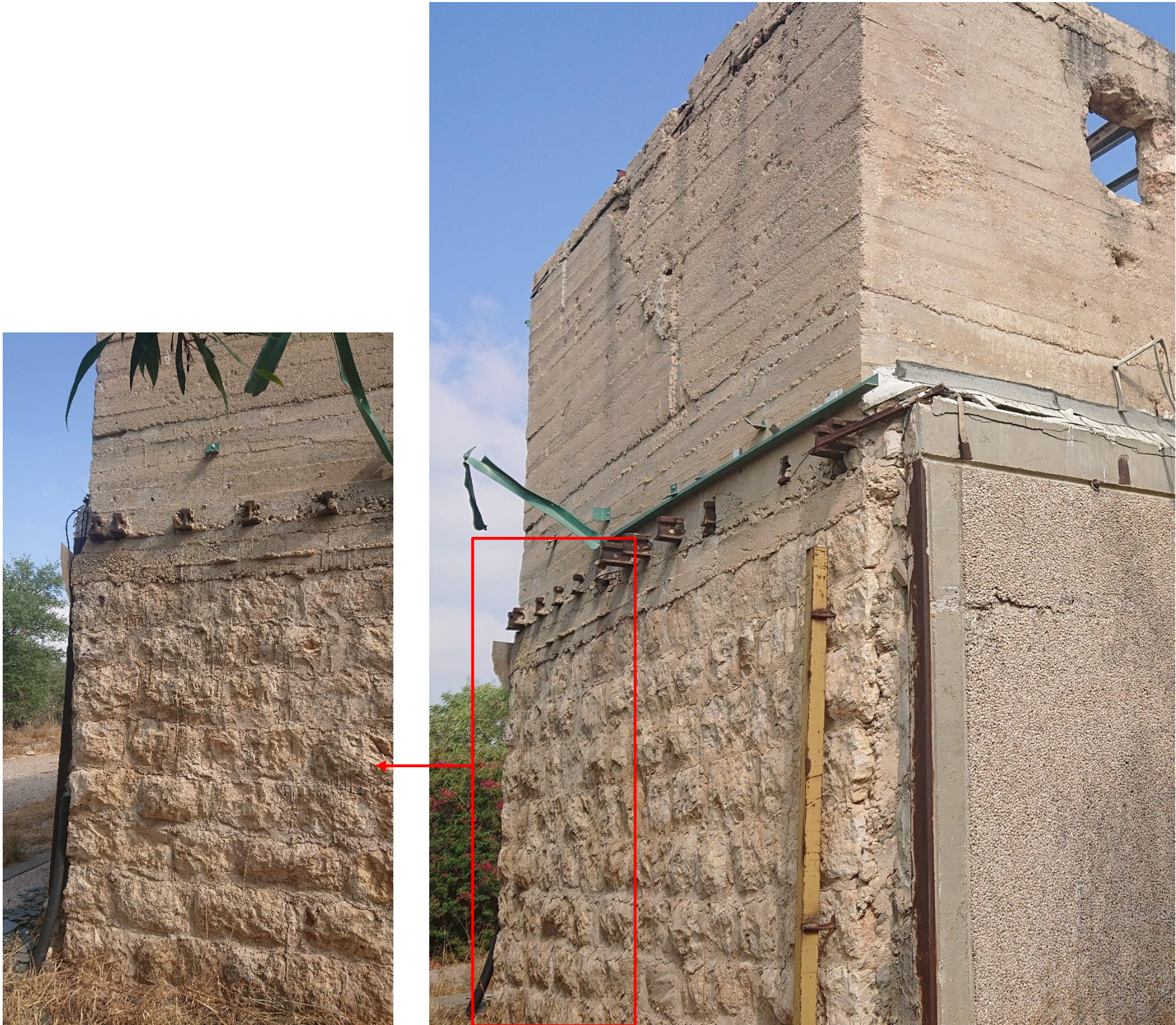
1. חזית דרומית של המבנה – במקור הייתה חזית זו בנויה מאבן גזית בסיתות גס. הקומה השנייה של המבנה – נבנתה יציקת בטון, על גבי תקרת בטון מאוחרת הנתמכת בפסי רכבת מפלדה, שנלקחו מהמסילה הצבאית שהייתה קיימת באתר עד לשנת 1921.
