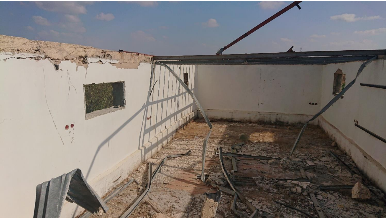
2 . תקרת המבנה / קומה עליונה: קירות מאוחרים, ניתן להבחין במעקה גג היקפי מקורי (נמוך) עליו נבנו הקירות. המשפכים הקיימים נאטמו באמצעות בטון ועליהם הונחה רצפת עץ מאוחרת.
