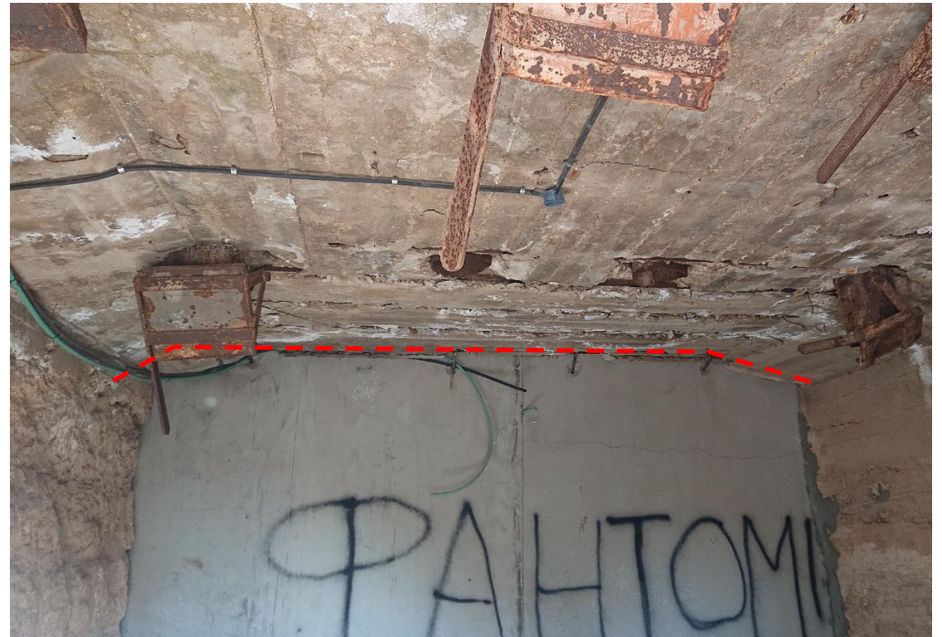
חתך תקרת הבטון – עיבוי של נקודת החיבור לקירות התומכים בתקרה על מנת לחזק אותה בפני מומנט פיתול. ניתן לראות בצילום קיר משלב א' (מימין) וקיר משלב ג' (מרכז התמונה) העשוי מבטון מתועש.
