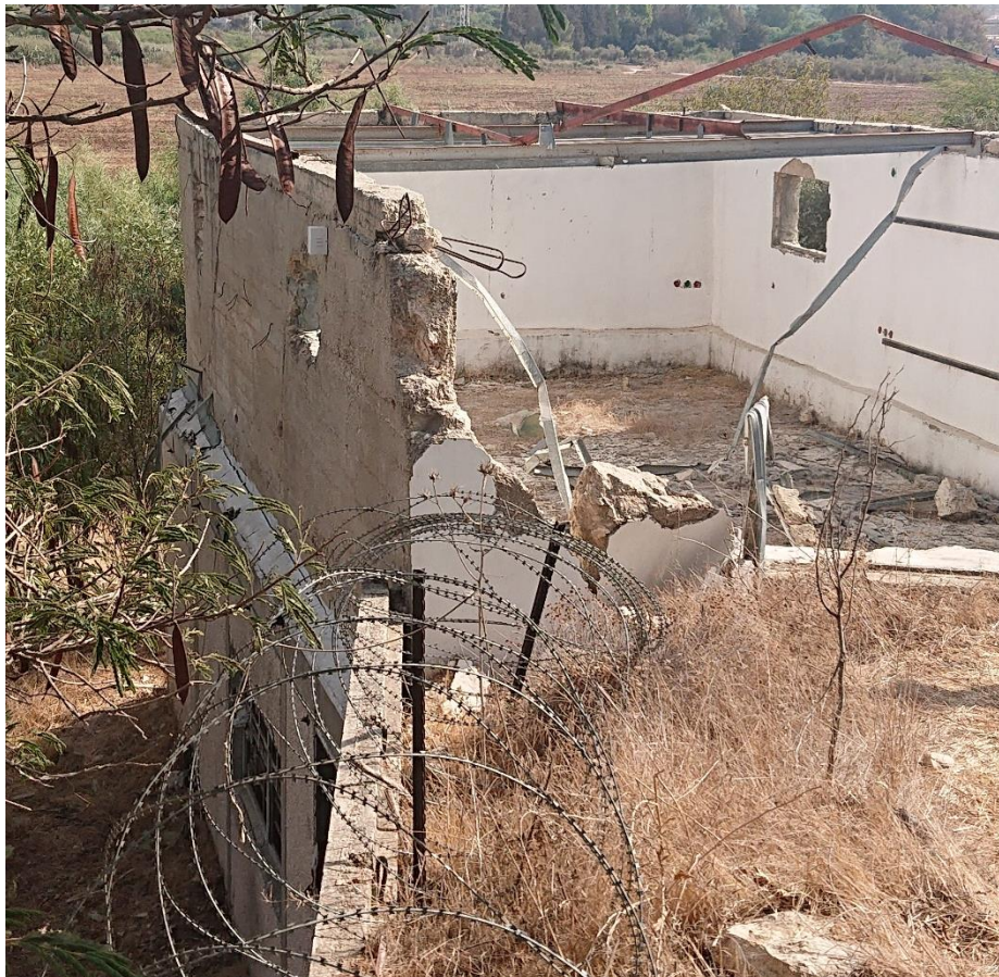
חלקו העליון של המבנה – קירות בטון משלב ב'. ניתן לראות את האופן בו קיר הבטון המאוחר משלב ג' "הולבש" על גבי המבנה ובולט מקו החזית המקורית.
