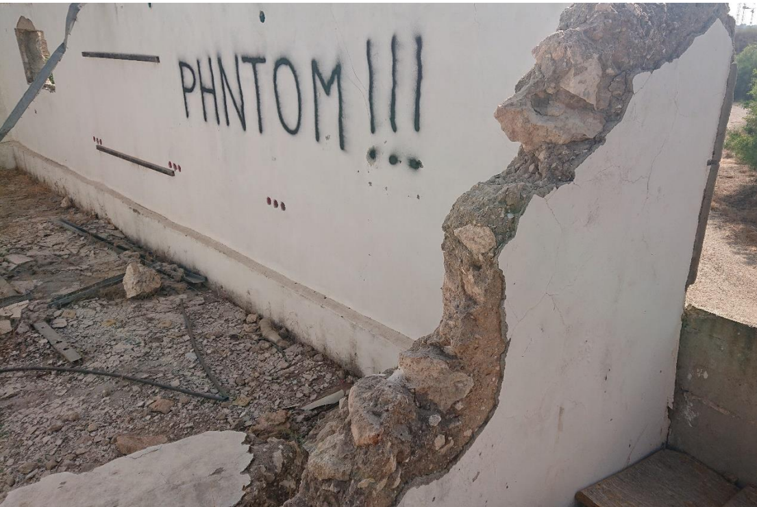
3 . תקרת המבנה / קומה עליונה: קירות מאוחרים עשויים אבן לקט וחומר מליטה ("קיר דבש") בחיפוי טיח ע"ב צמנט.
