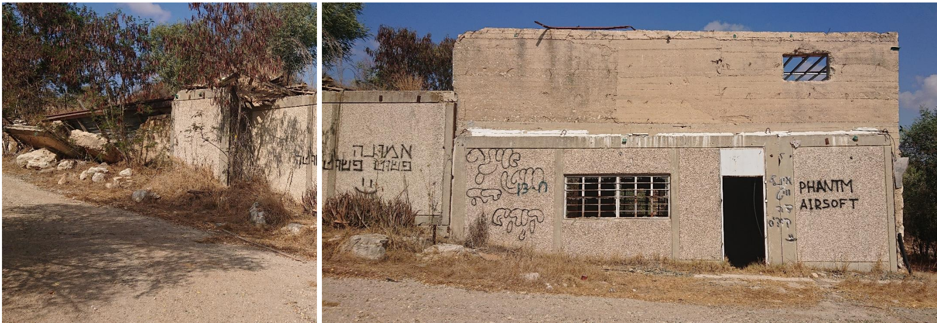
1. חזית מערבית של המבנה – משתנה בהתאם לטופוגרפיית האתר. החזית חופתה בשלב מאוחר בלוחות בטון בשילוב אגרגט, במקור הייתה פתוחה.
