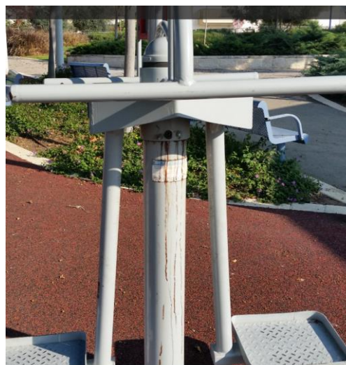
ציר שבור, מתקן מתנדנד באופן בלתי תקין בגן ברחוב הדקל
