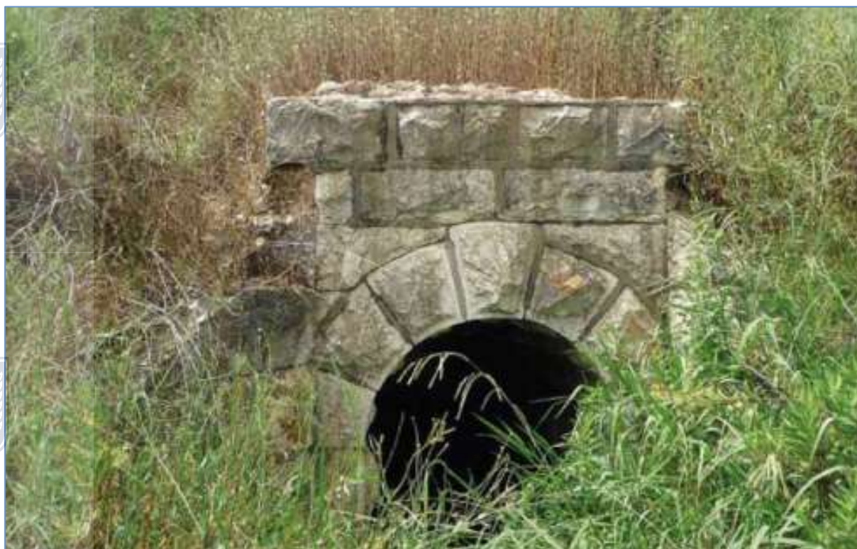
איור 46 - גשר נחל בית עריף
